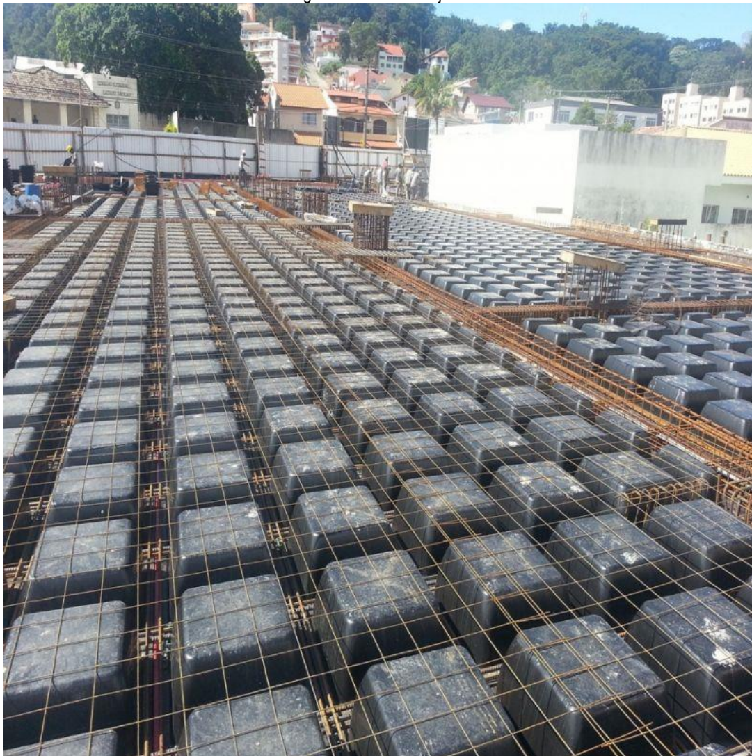
Figura 15 Pannel de laje armada
