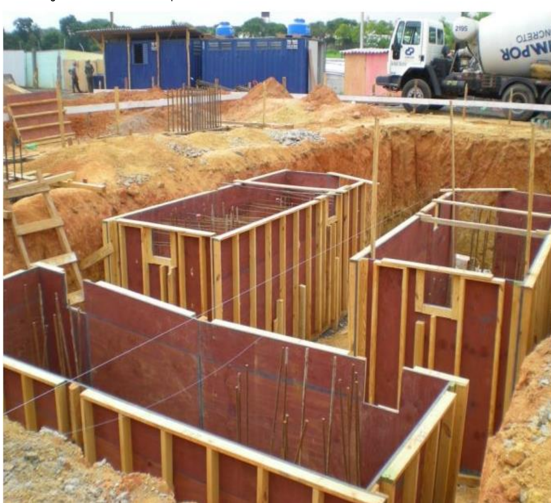
Figura 5 Forma dos blocos posicionada e arames dos eixos esticados – Fonte Universidade TRISUL
