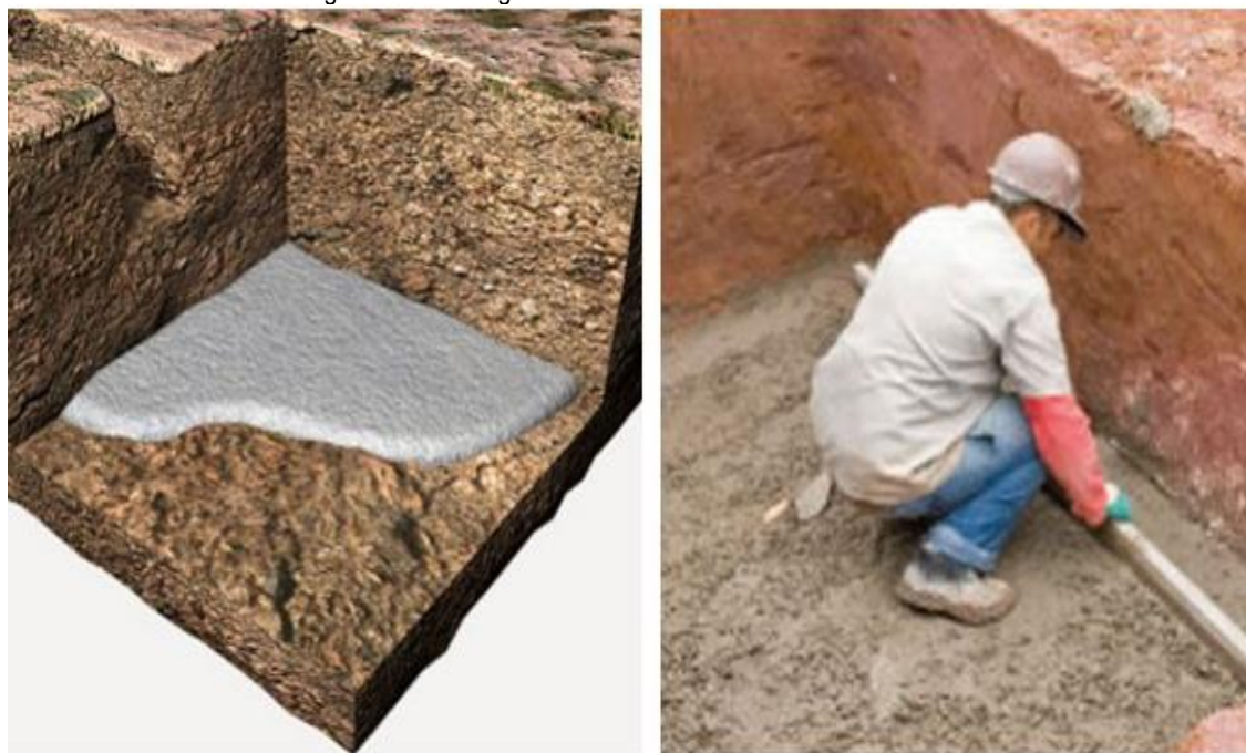
Figura 4 Concretagem do lastro - Fonte Universidade TRISUL
