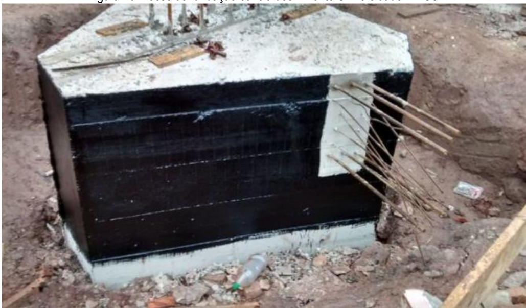
Figura 10 Blocos de fundação concluídos – Fonte Universidade TRISUL
