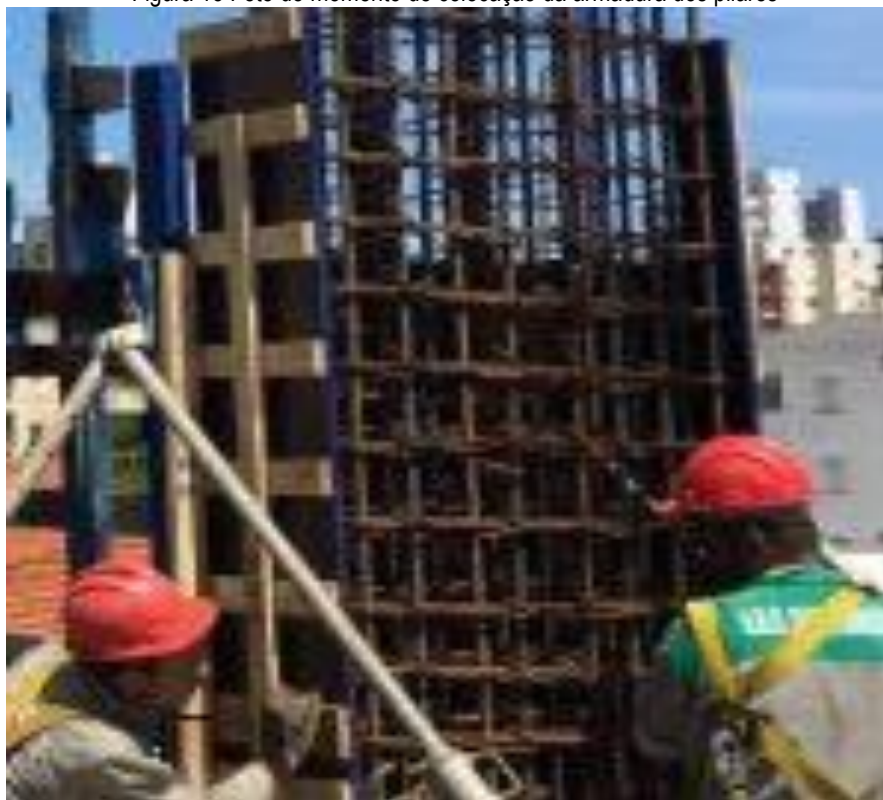
Figura 13 Foto do momento de colocação da armadura dos pilares
