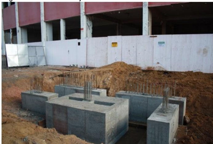
Figura 9 Blocos de fundação concluídos – Fonte Universidade TRISUL
