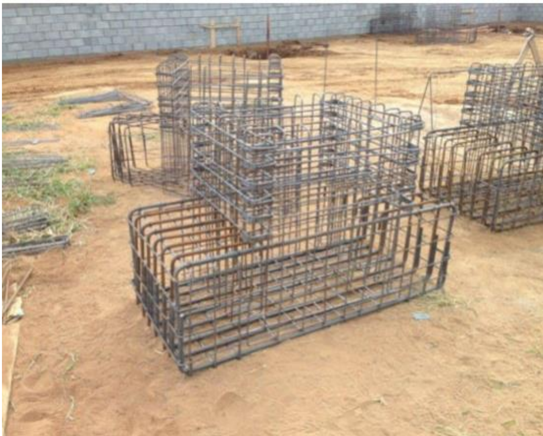
Figura 8 Armadura para blocos de fundações – Fonte Universidade TRISUL
